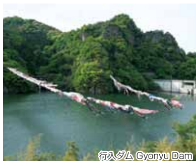
行入ダム Gyonyu Dam
